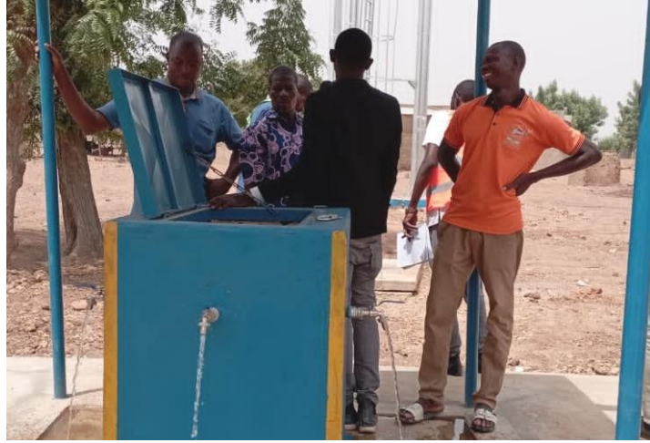
Ein neuer Brunnen, von Solafrique gebaut
